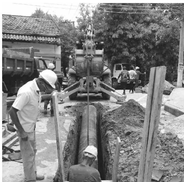
Funcionários colocam a tubulação no Centro da cidade
