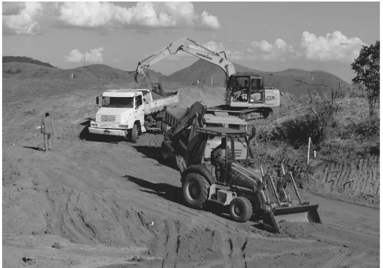
Área onde será instalado o reservatório no Morro do Melo, no bairro Metalúrgica
